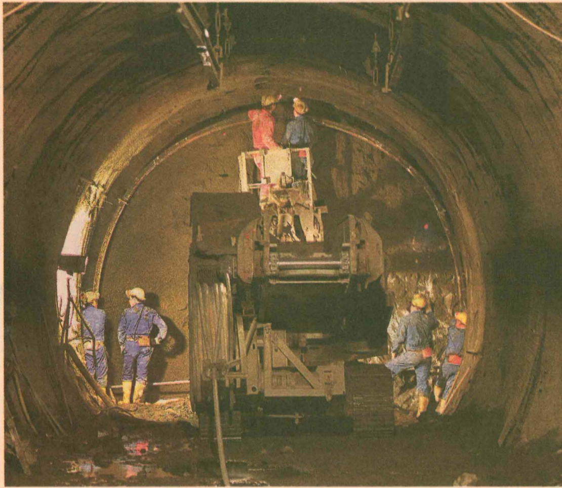
Dicke Bretter, tiefe Stollen? In der Politik muss jedenfalls viel gebohrt (im Bild der Semmeringtunnel) werden, damit etwas vorangeht. Steuererhöhungen allerdings treiben die Dinge nur bedingt voran.
